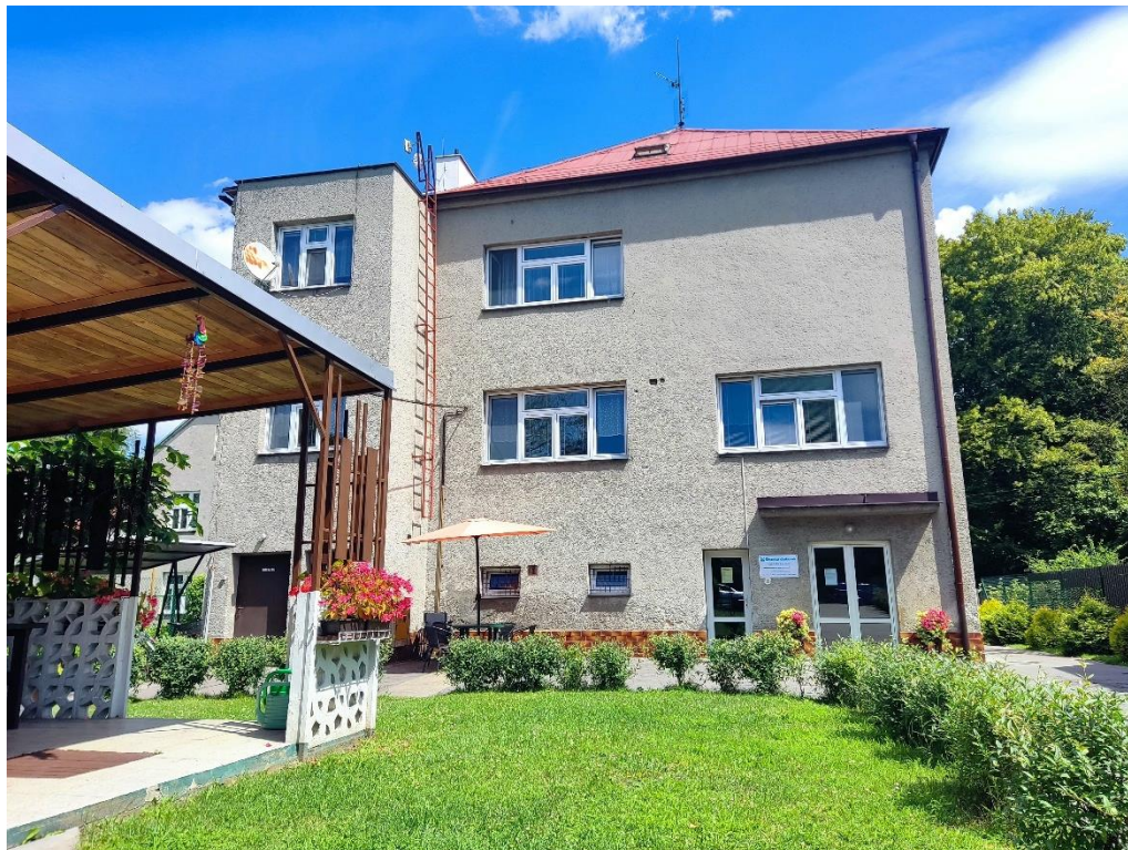
BUDOVA – POHLED Z PŘÍJEZDOVÉ CESTY
